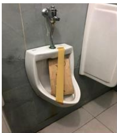
Gambar 1.2 kondisi Existing toilet di site
